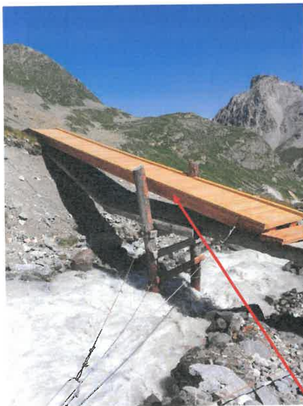
Vue amont lors de la pose en 2016
