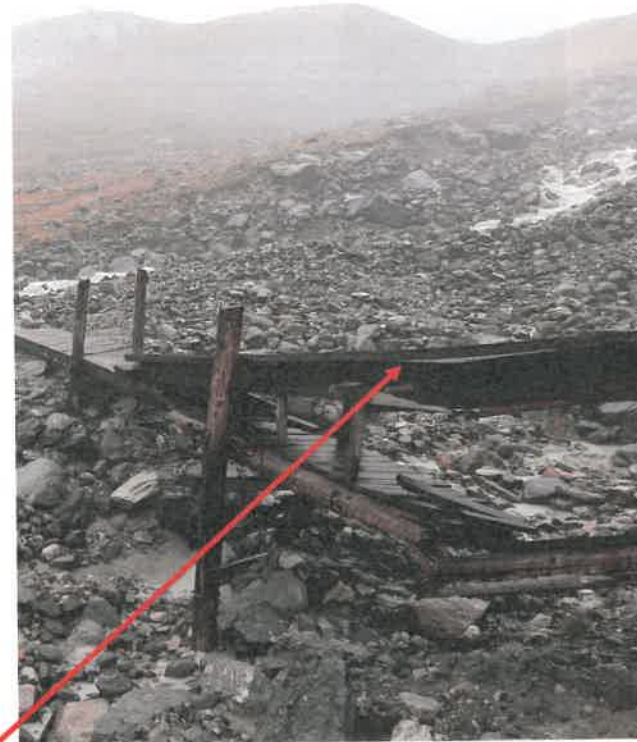
Vue aval à la fin de l'été 2021
